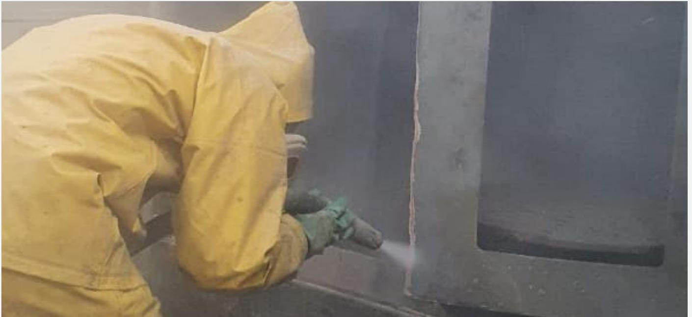
*Limpieza de superficie por VaporBlasting*
