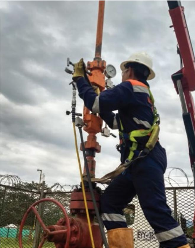
Instalación de lubricador
